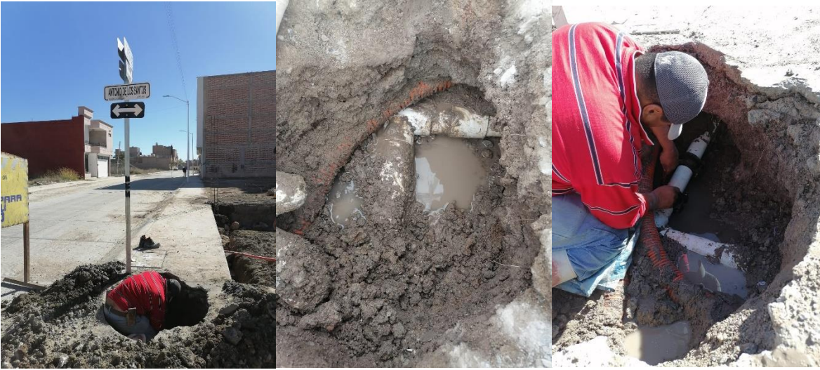
Instalación de válvulas en diferentes puntos de la calle Álvaro Obregón
